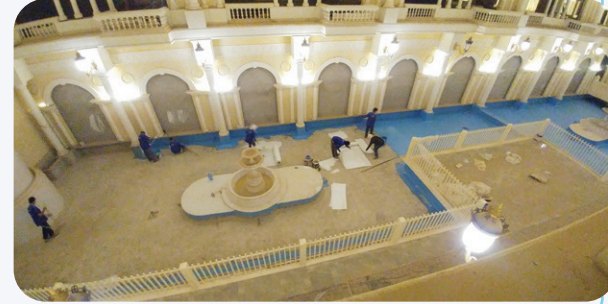
مشروع بحيرة مائية في مجمع تجاري بتليس الخرسانة بالفيبرجلاس
